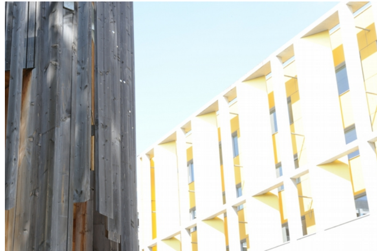
Centrale pondérée en visant le bois
